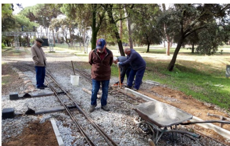
6 abril - Col·locació de biguetes per fixar la grava de les agulles diagonals de terme.
