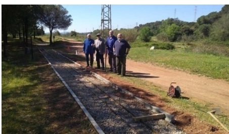
4 maig - Col·locació de biguetes per fixar grava a la recta de la trinxera.
