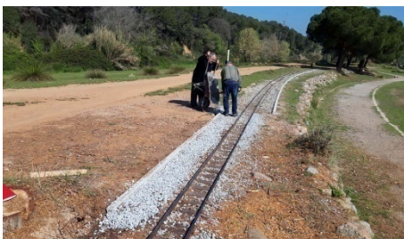
13 abril - Col·locació de biguetes i acabament del clavegueró al Pi Gran.
