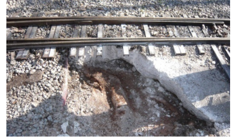
Dimensió de l'arrel i l'alçada del formigó.
