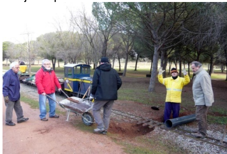
Inici de la construcció del clavegueró
