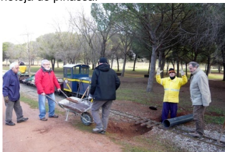
Inici de la construcció del clavegueró
