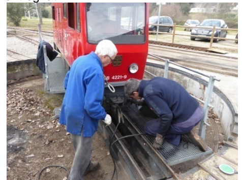
Moment de la soldadura.
