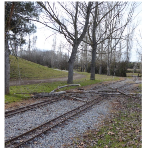
Aspecte de la branca sobre la via.
