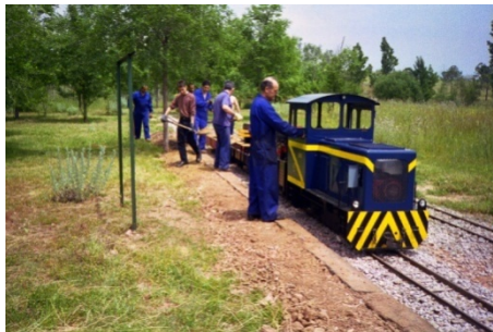
La brigada de via i obres acabant l'andana.
