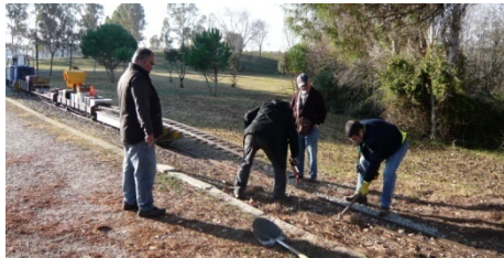
Re anivellament després del pas de material.
