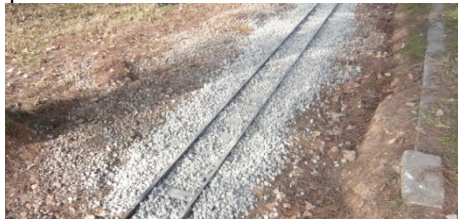
Balast i primer anivellament
