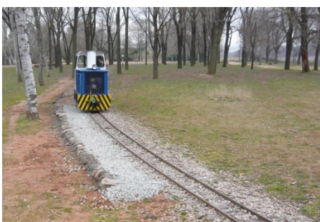
Una part del muret en construcció.
