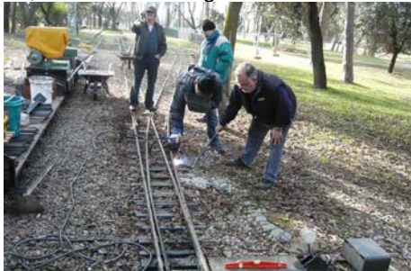
Feina de col·locació i soldadura de les travesses suplementàries.
