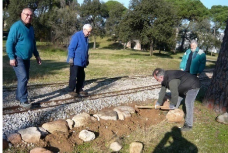
Construint el muret de reforç del balast.
