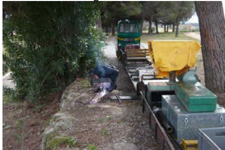
Moment de la soldadura.
